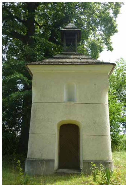
Pohled na zvonici s dřevěnou střechou
