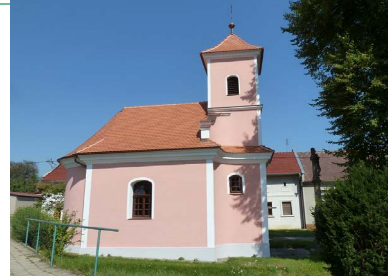
Kaple po opravě z bočního pohledu
